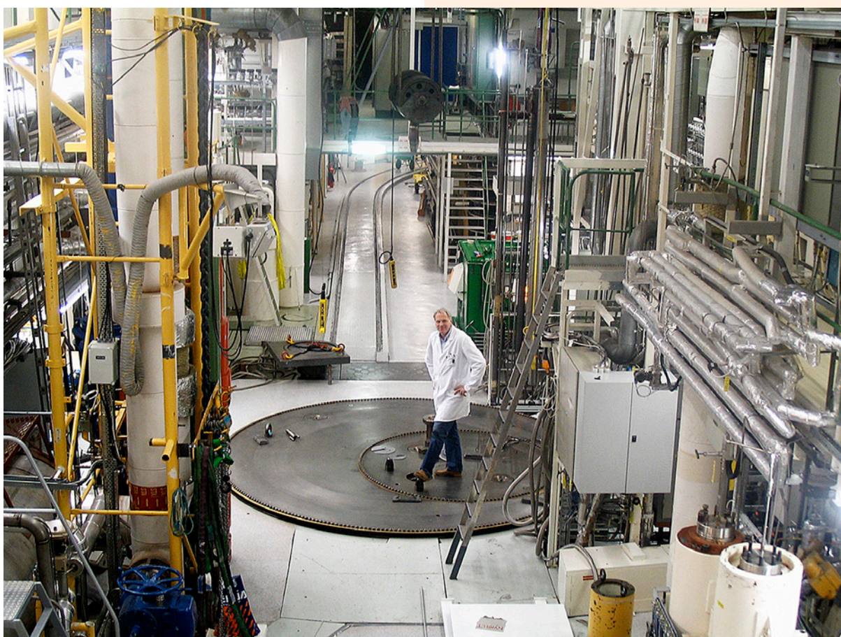
Haldenreaktoren er en 25 MW tungtvannsmoderert og -kjølt kokvassreaktor. Reaktoren var i drift ca. 50 % av året. Resten av tida ble brukt til vedlikehold og inn- og utlasting av eksperimentelt utstyr og brensel. Foto: IFE
